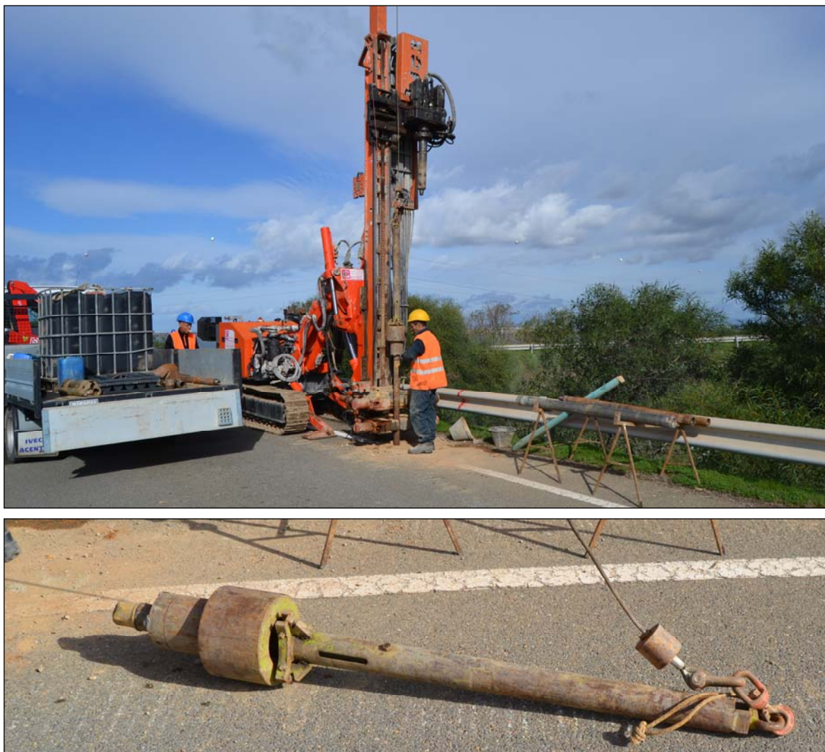
Foto 4.4 – Esecuzione prova SPT in S1; in basso particolare dell'attrezzatura utilizzata
